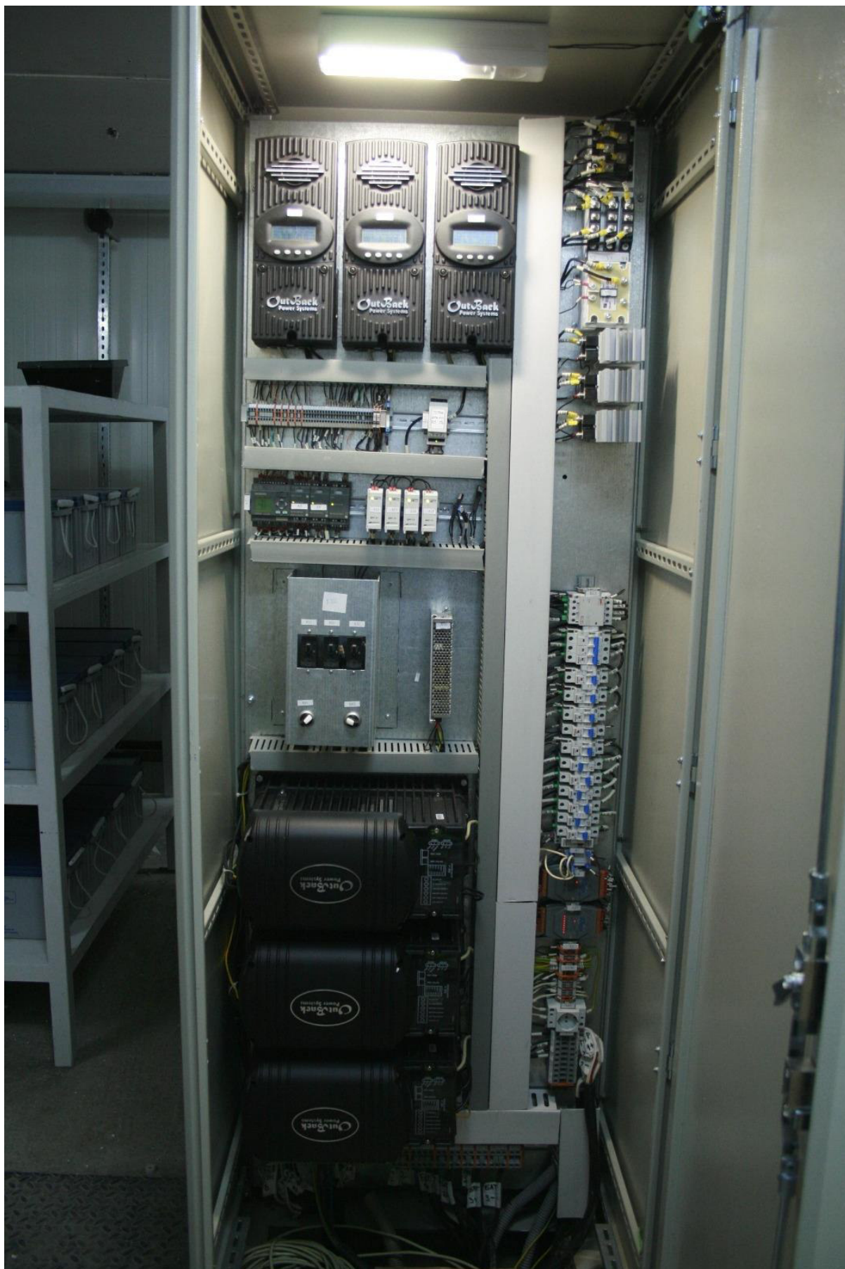
Рисунок 6.12 – Системы управления ВРТБ, в которых проводились испытания
