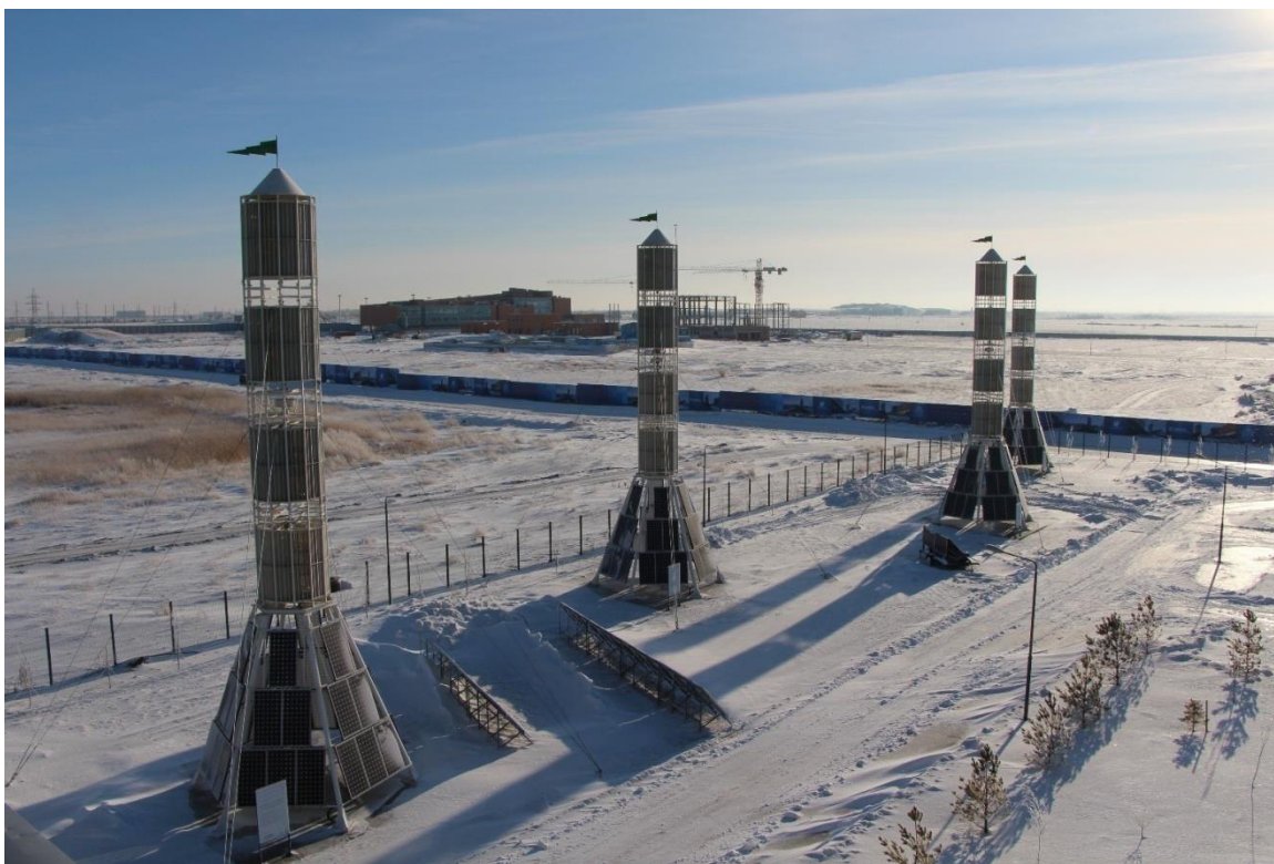
Рисунок 6.10 – ВРТБ установленные в городе Астане
